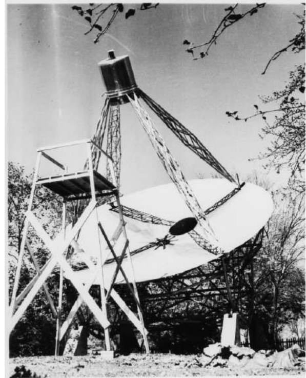
Figura 6: O radiotelescópio de 9 m de Grote Reber em 1937. Fonte: NRAO/AUI, www.flickr.com/photos/itu-pictures/16660555401 .
